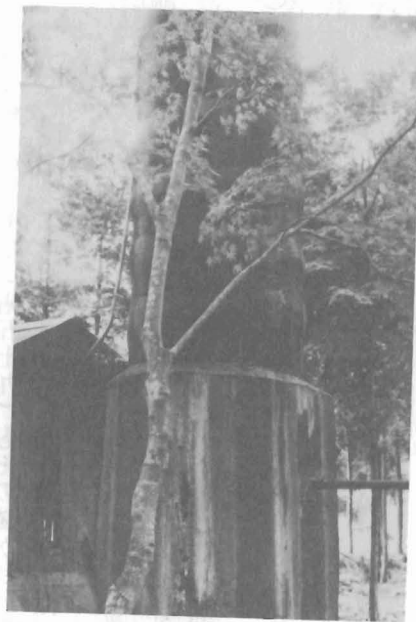
(簡易水道水源地のタンク)
