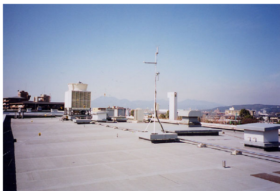
写真 環境共生学部旧棟屋上全景
