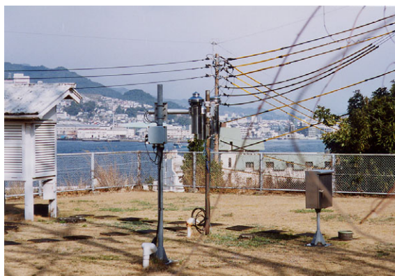
写真 長崎海洋気象台の露場
