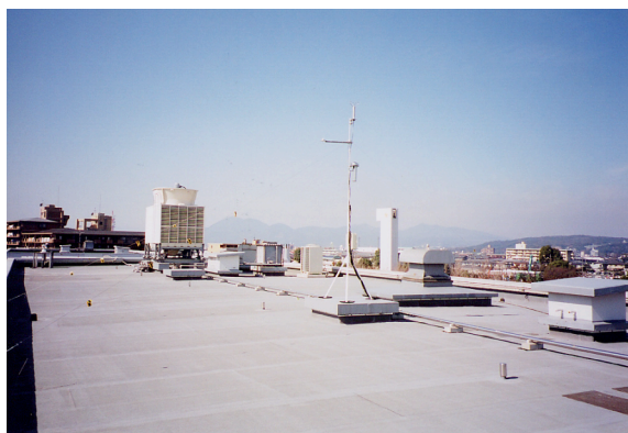
写真 環境共生学部旧棟屋上全景
