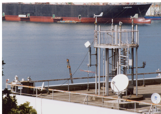
写真 長崎海洋気象台の測風塔
