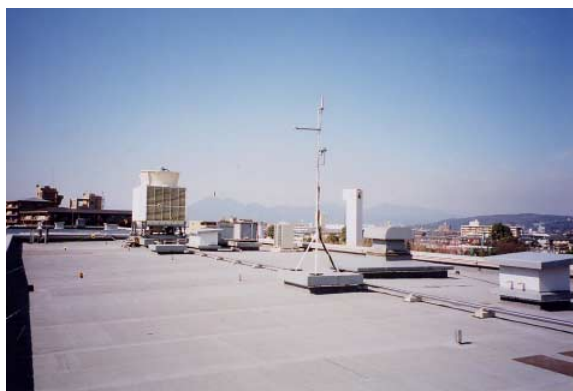
写真 環境共生学部旧棟屋上全景
