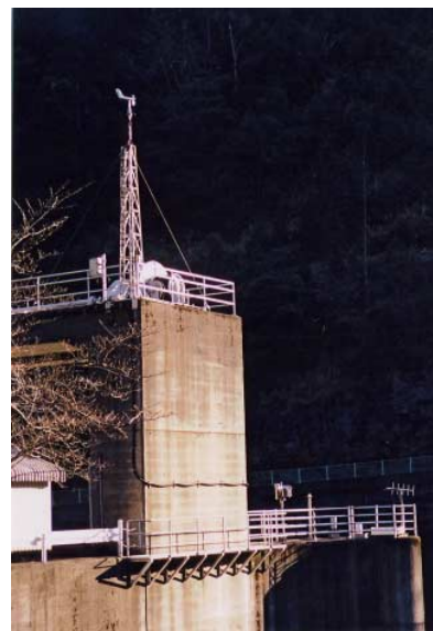
写真 大平ダムの気象観測施設
