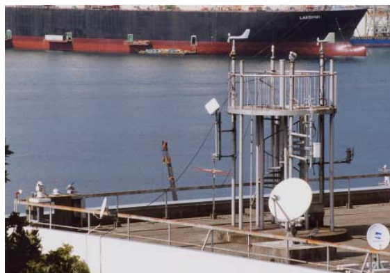
写真 長崎海洋気象台の測風塔
