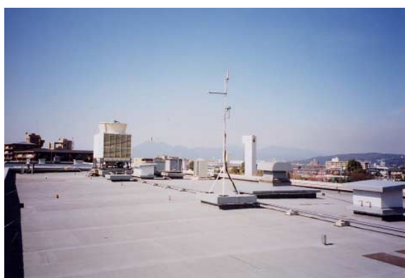
写真 環境共生学部旧棟屋上全景
